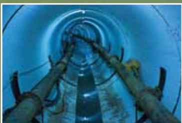
VISTA INTERNA DE UN TÚNEL CURVO.
