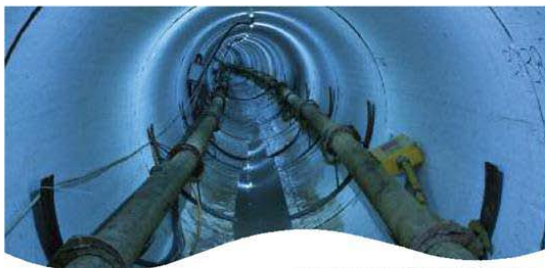
Ariba: Vista íntima de la porción curvada de la Extensión del Interceptor de la Avenida Homestead, instalado mediante tecnología de túnel de tubería "trenchless", que representa la primera vez que esto se ha completado en los Estados Unidos. Arriba: MDC, AECOM y el personal de NE Remso de pie por encima de la fosa donde la máquina de perforación perforo tal como planificado.
